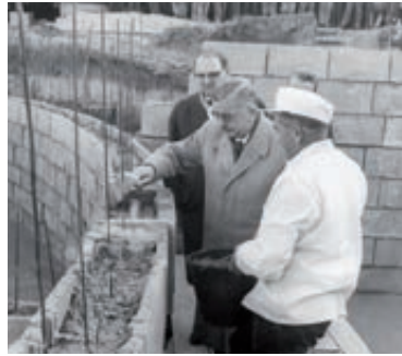
Landeshauptmann Leopold Figl bei der Grundsteinlegung für den Trinkwasser-speicher in Friebritz im Jahr 1963
