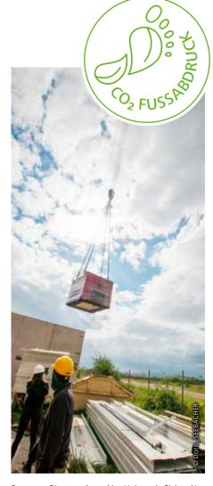
Der neue Biomassekessel im Heizwerk Civitas Nova sichert die Naturwärmeversorgung für die Zukunft ab – hier bei der Anlieferung.
