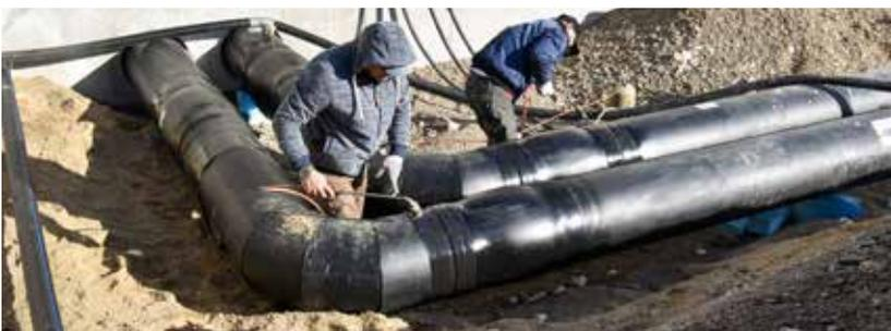
Auch die Leitungen für Vor- und Rücklauf und damit auch der Anschluss an das Fernwärmenetz sind bereits vorbereitet.
