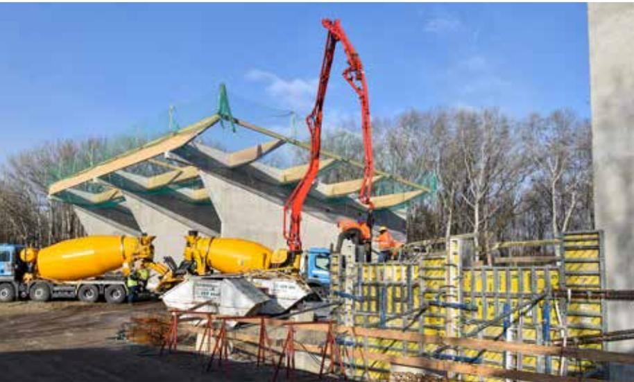
Zwischen dem Krafthaus (rechts) und dem Hackgutlager (links) entsteht ein Löschwasserbecken mit einem Fassungsvermögen von 400 m<sup>3</sup>.
