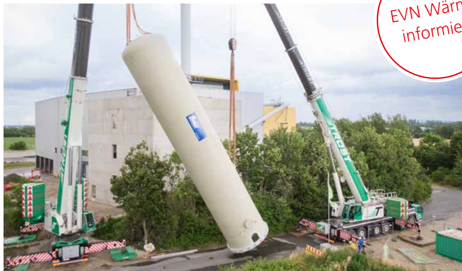
Der 50 Tonnen schwere, 24 Meter hohe Pufferspeicher wurde mit zwei Kränen millimetergenau auf seinen Standort gehoben.
