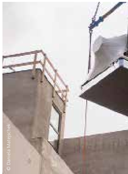
Die 62 Tonnen schweren Bauteile werden mittels Kran von oben in das Gebäude eingehoben und präzise an der vorgesehenen Stelle platziert.
